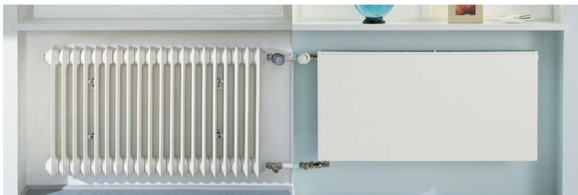
Wymiana starego grzejnika żeliwnego...
